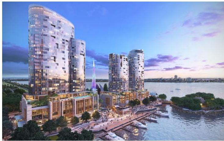
The Towers at Elizabeth Quay, 柏斯 320,000 平方尺可销售面积 379 单位
