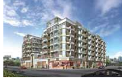
位於香港沙頭角之住宅地盤
