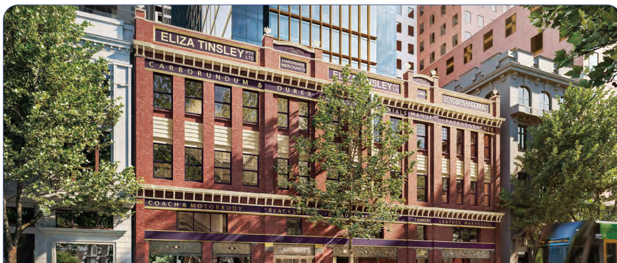
墨爾本之640 Bourke Street
