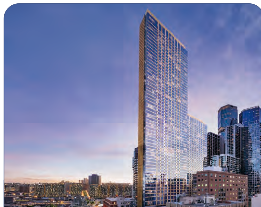
墨爾本之640 Bourke Street
