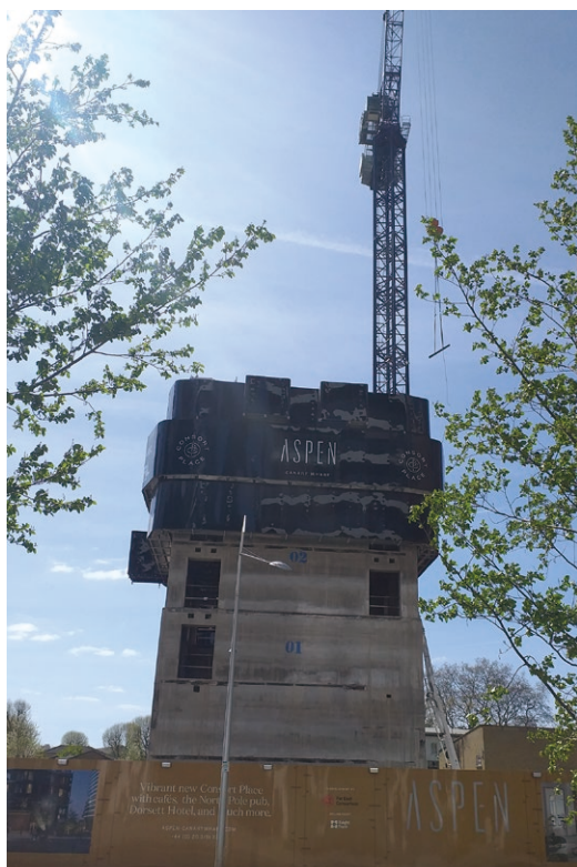
倫敦Aspen at Consort Place建築地盤
