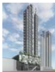
位於香港大圍之發展地盤
