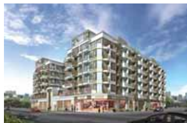
位於香港沙頭角之住宅地盤
